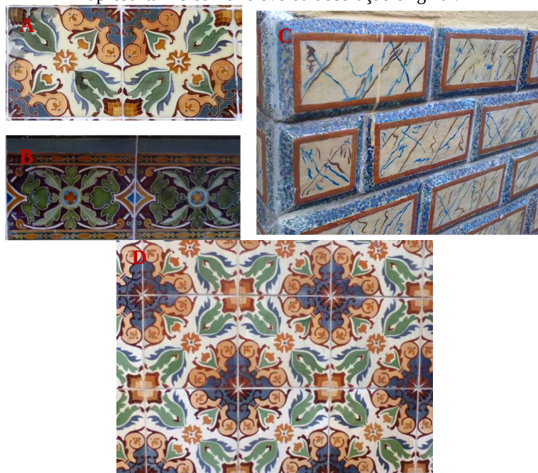
Figura 28 – A) Azulejos originais da fábrica Villeroy & Boch , com decoração em baixo relevo; B) Cercadura original, da fábrica Villeroy & Boch , com decoração em baixo relevo; C) Frisos originais, procedentes da cidade do Porto, com arestas chanfradas; D) Pannel de réplicas do azulejo alemão, constituído por azulejos lisos, que não apresentam o baixo relevo da decoração original.
